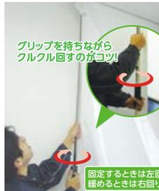
③天井に到達したらバーを回転させ、定着するまで微調整します。
